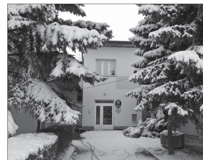
Zateplení budovy OÚ
