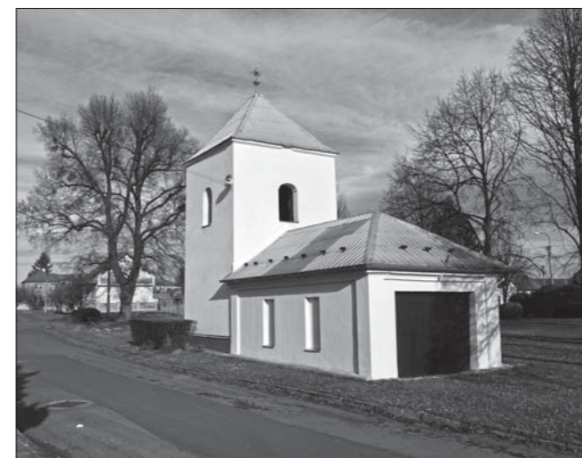
Oprava zvonice na návsi
